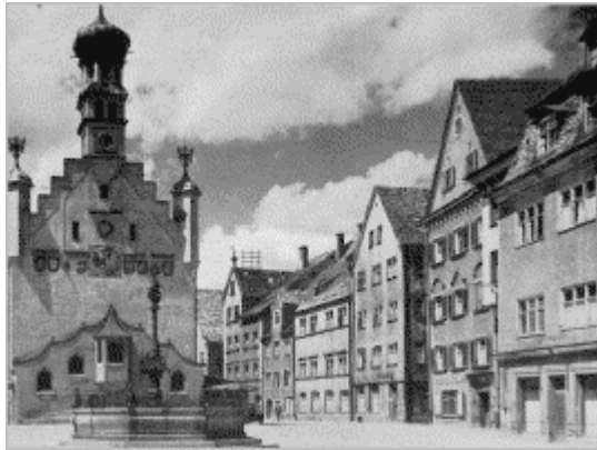
Abb.: Kempten vor der „Sanierung“ (s.Fußn.4)
