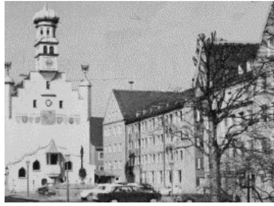
Abb.: Kempten nach der „Sanierung“
